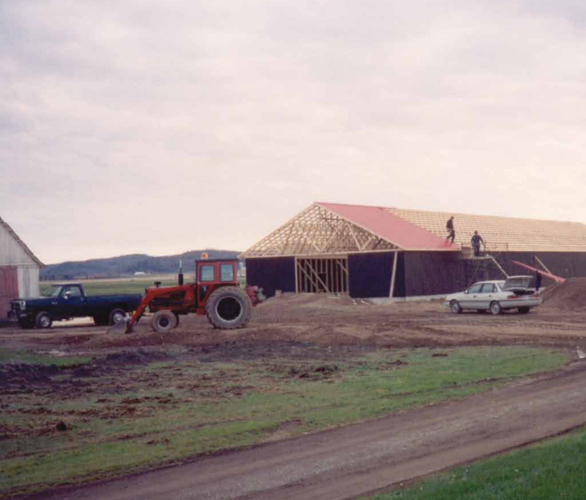
Construction d'un bâtiment d'élevage de poulettes, en 1993.
